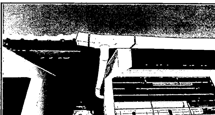
Foto 6: Canales y bajadas de agua pluvial en mal estado.
